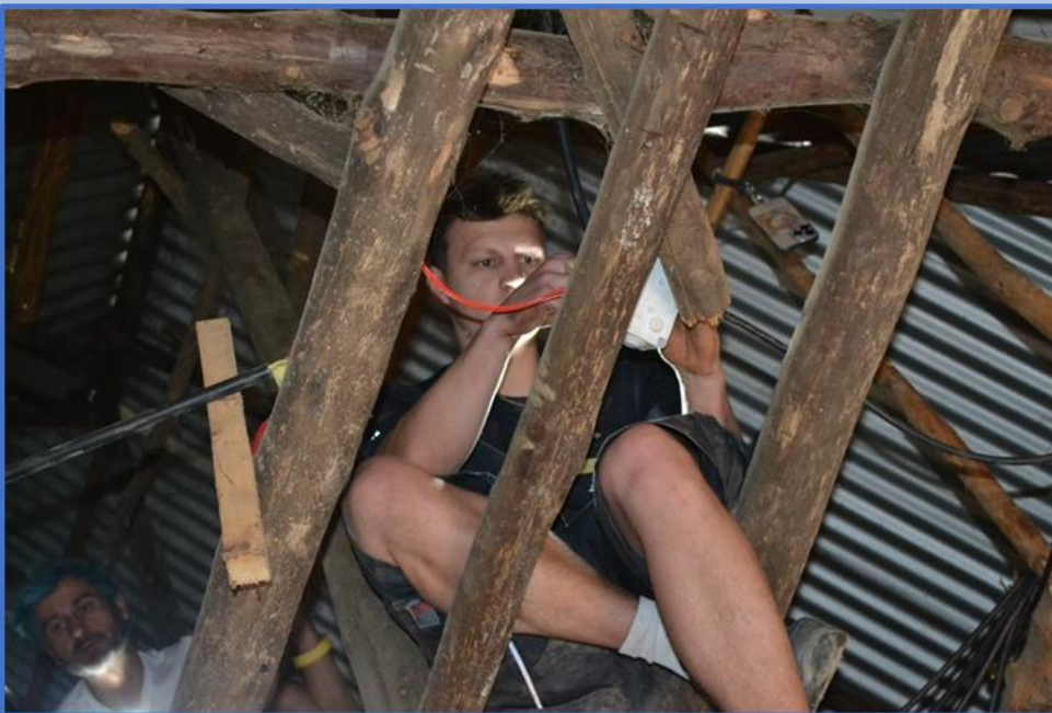
Moritz Tresp in luftiger Höhe im offenen Gebälk beim Verkabeln, assistiert von Dominik Kogge (links).
